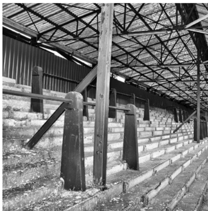
Bovenstuk van de steunpaal met reling van de overdekte statribune.
