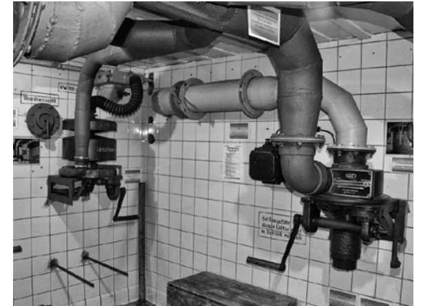
De machinekamer voor de luchtverseringsinstallatie. ➤
